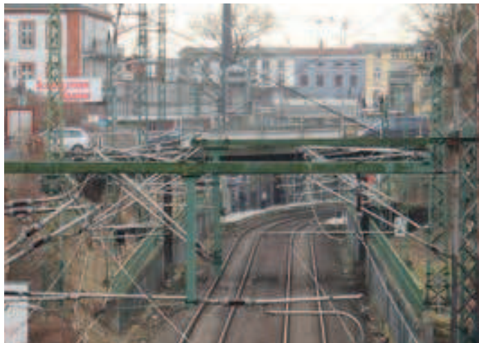
Blick auf die Brücke in der Wittenburger Straße von der Brücke in der Franz-Mehring-Straße
